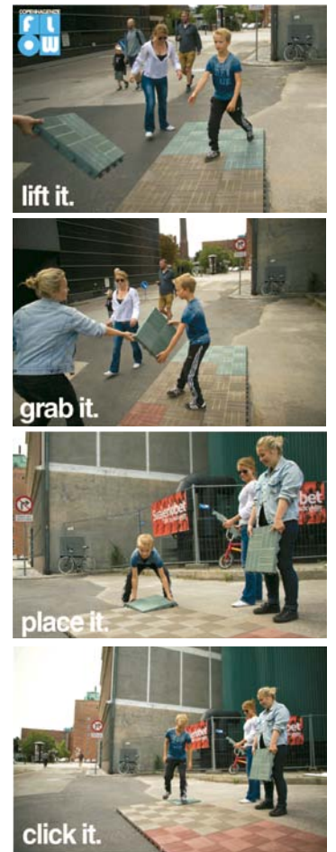
Instalación de los carriles-bici de la marca Copenhagen, un nuevo modo de apostar por la sostenibilidad.
